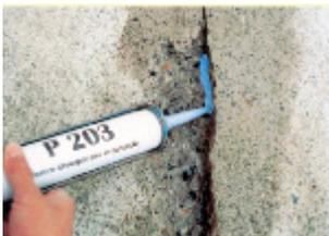
Scarifica sino ad una profondità minima di 7 cm delle fessurazioni od attorno ai corpi passanti, sigillatura degli scassi con formazione di cordolo continuo del diametro minimo di 1 cm mediante applicazione di gomma idroespansiva in cartuccia
